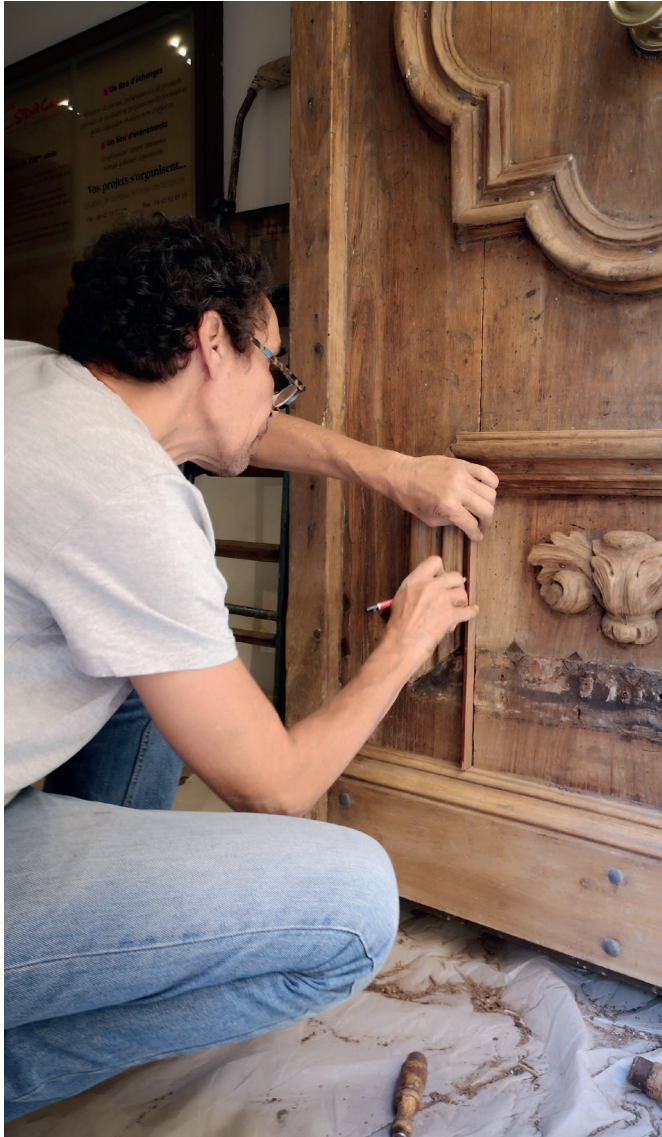
Restauration de la porte de l'Hôtel de Coriolis : prise de mesure du phillippot (baguette de bois de la même essence que la porte d'origine)
