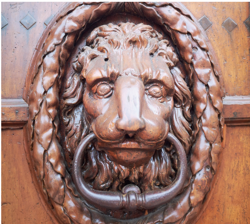
Porte de l'Hôtel de Ville Tête de lion en cours de restauration - atelier Tournillon. Voir p.28 n°6 sur carte.
