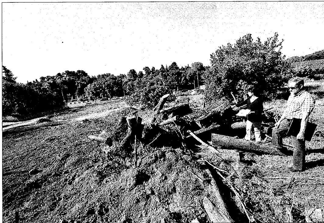
Francis Moigne et Anne-Marie Magal habitent à quelques mètres des travaux. Ils ne peuvent que constater les dégâts. Et craignent de perdre le caractère rural du quartier.
